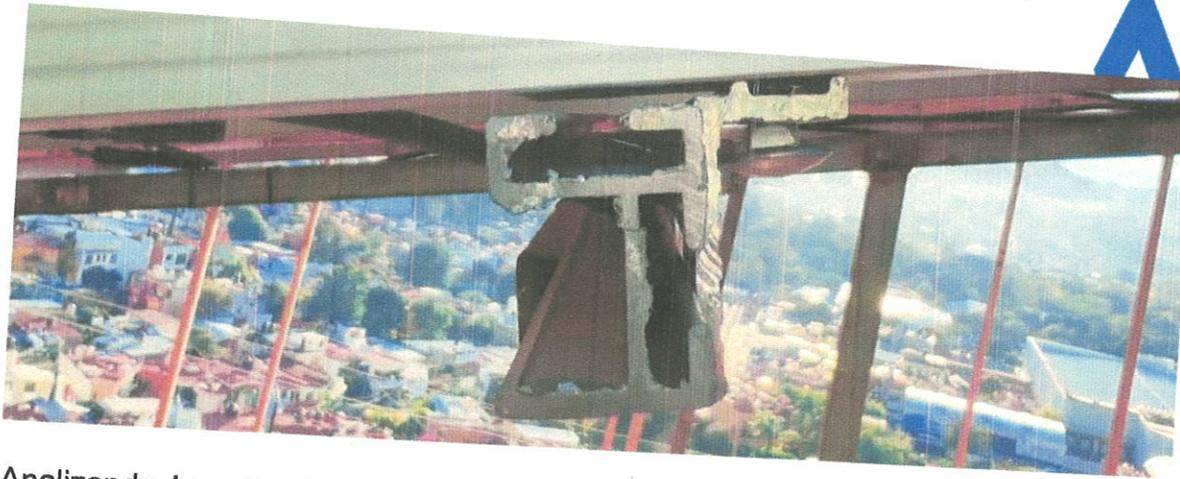
Analizando la estructura de PTR también encontramos malas prácticas, de las principales es el montaje de riel al PTR, debido a que se trata de dos tipos de materiales (aluminio y acero) se deben separar por un aislante de plástico, esto para evitar el efecto Par Galvánico el cual daña ambos materiales al punto de oxidarlos a gran velocidad, reduciendo así la vida útil de ambos materiales.
