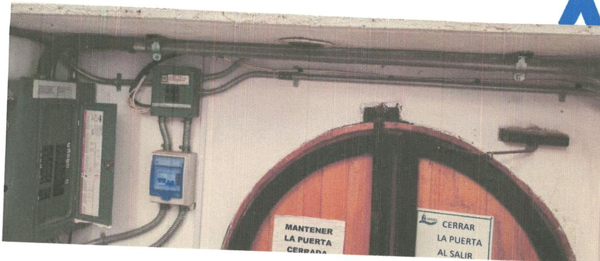
Todos los medios de desconexión del sistema fotovoltaico en corriente continua deben estar etiquetados como indica el artículo 690-53 de la NOM-001-SEDE-2012, en los medios de desconexión del sistema no se muestra ningún etiquetado.
