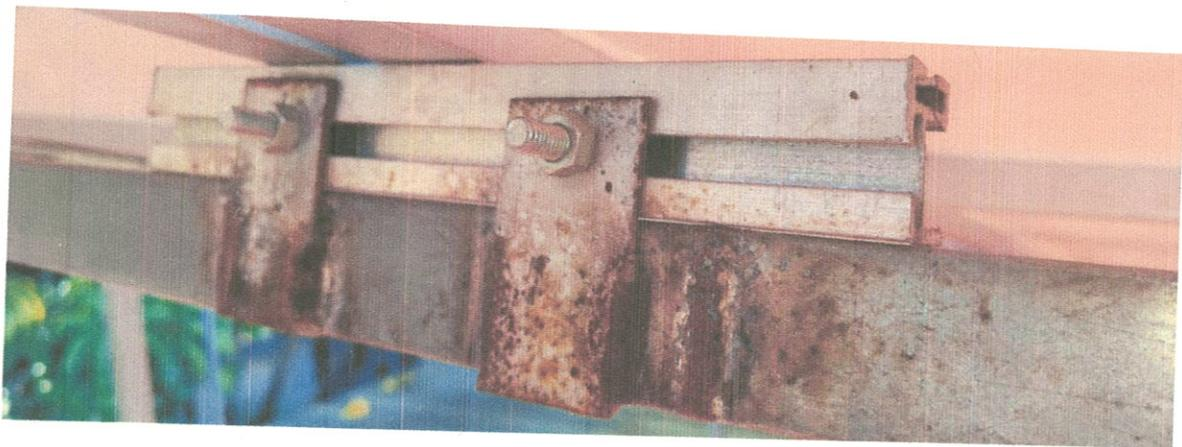
La mayoría de la estructura de PTR fue construida por pedazos de perfiles, pues se observan varias partes que están unidas a través de soldadura la cual ya presenta oxidación.
