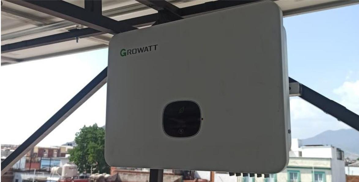
Conexión eléctrica en corriente directa del inversor, el trayecto de este cableado es desde los string de modulos hacia las terminales del inversor.
