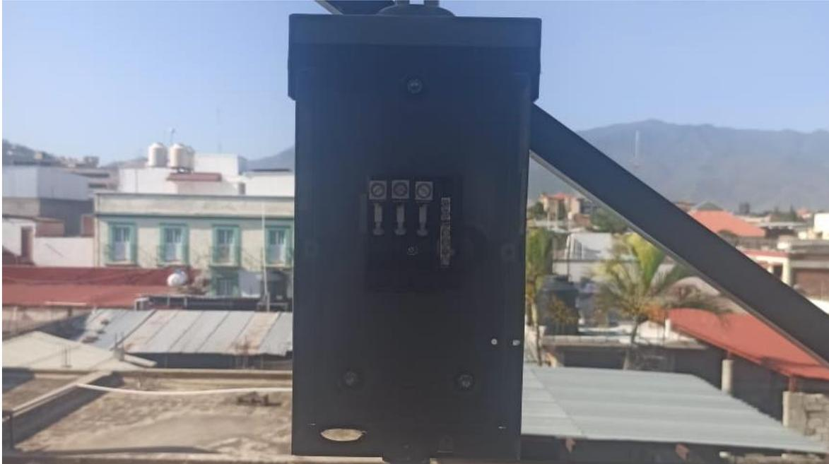
Se realizó el cableado del centro de cargas del inversor hacia el centro de cargas general del laboratorio.
