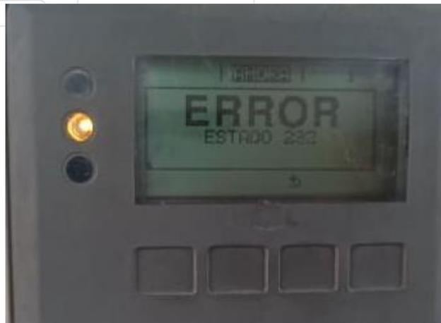
Dicho código trata de un sobre voltaje o de un bajo voltaje en la línea 3 de corriente alterna, al realizar las mediciones eléctricas de voltaje y corriente nos percatamos que están dentro del rango permisible por el inversor, por lo que se apagó y volvió a encender el inversor para realizar una prueba de inicio, el inversor al iniciar marca lo siguiente:
