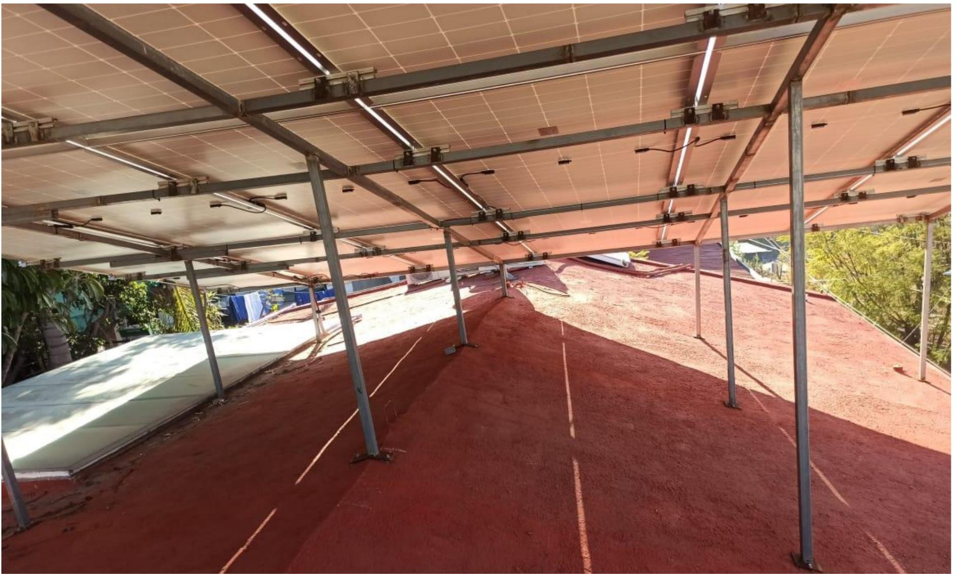
La estructura de PTR del sistema comienza a oxidarse, además de la mala colocación de la estructura de aluminio para el montaje de los módulos, la cual ya comienza a presentar par galvánico.
