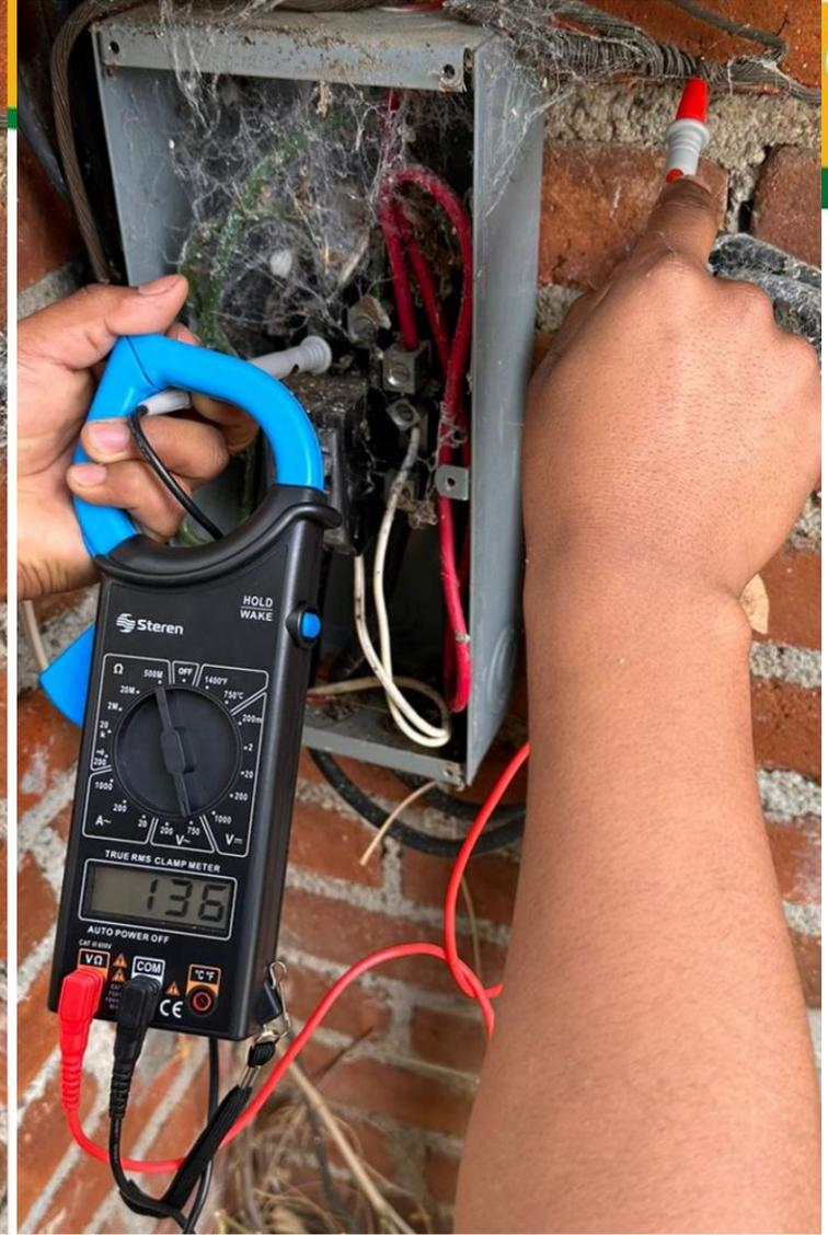
Medición de voltaje entre neutro y puesta a tierra.
